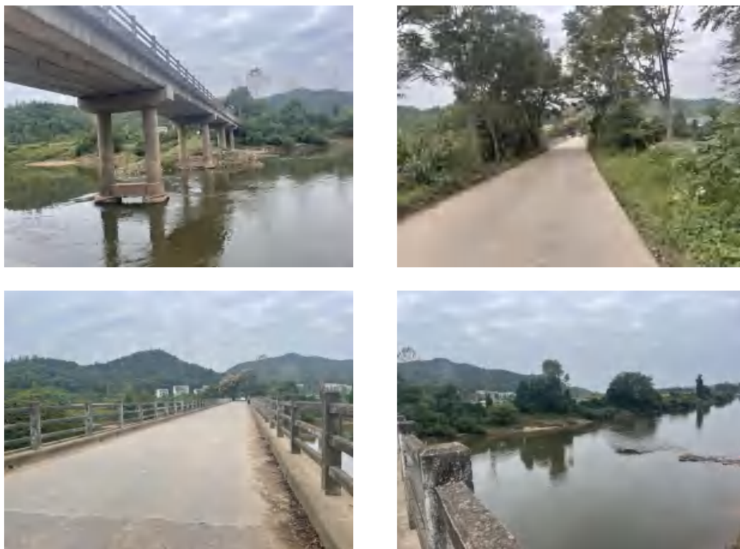
施工现场照片
