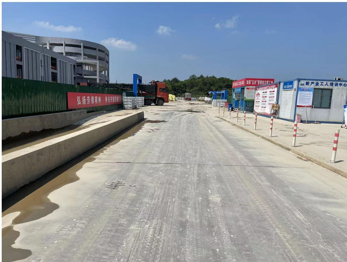
图 1-13 施工临时道路现状图
